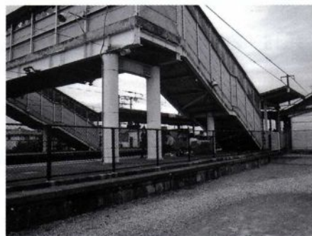
老朽化した稲枝駅舎
